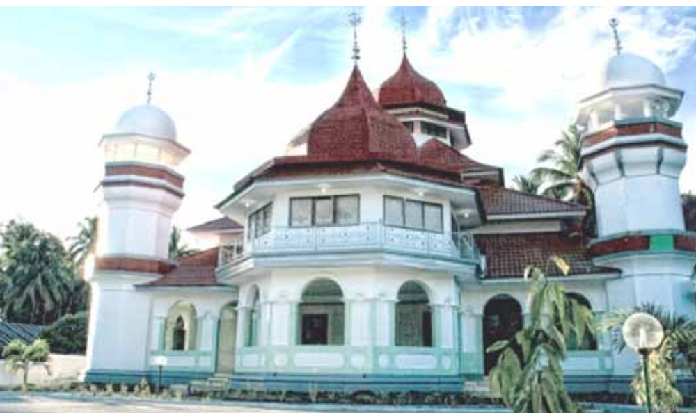
Rekonstruksi bangunan masjid Syekh Burhanudin di Padang Pariaman, Sumatera Barat. Foto-foto: Dok. DD Konstruksi
